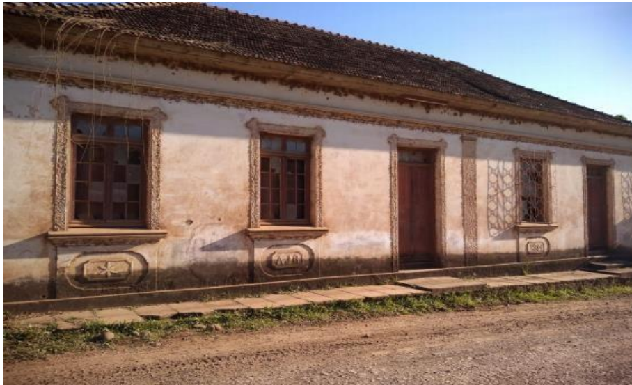
Figura 12: Casarão Ritter - Fonte:Travessias.
