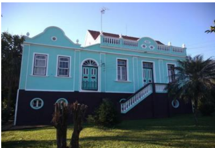
Figura 13: Casarão Nid - Fonte:Travessias.
