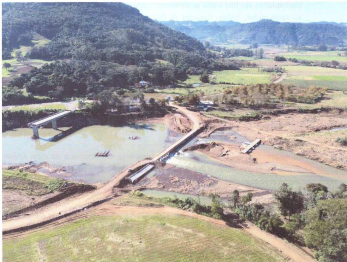
Vista Aérea Geral da Ponte Após Sinistro
